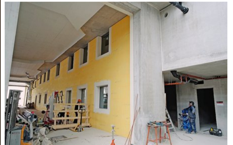
Le chantier est situé le long de la route de Meyrin. L. GUIRAUD
