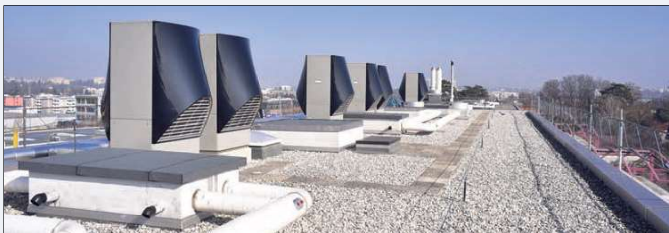
Substituer au chauffage fossile des pompes à chaleur installées sur le toit.
