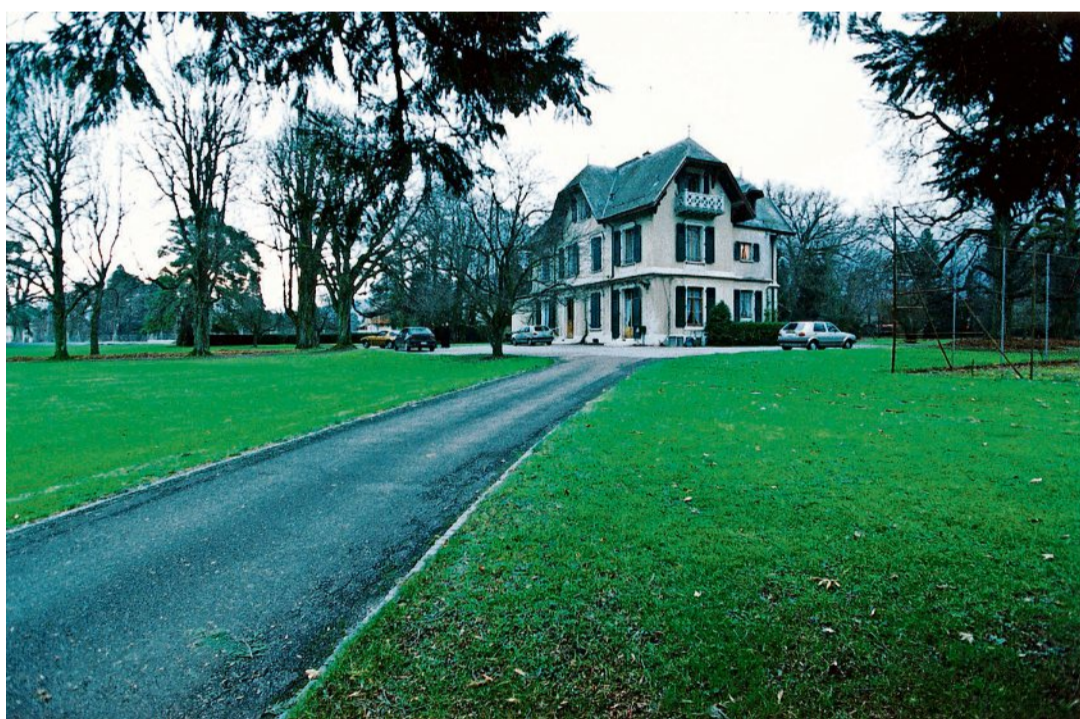
Rue de la Chevillarde, la maison Rosemont risque fort d'être démolie, faute d'être classée.
